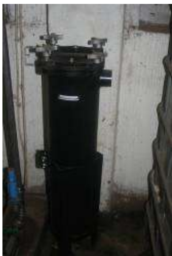
Figura 18 Filtro de bolsa con armazón de acero inoxidable (sin bomba o tanque de almacenamiento), en Diligent Tanzania ltd.
